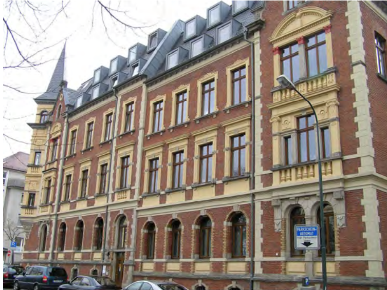
Fulda, Sturmiusstraße Nr. 05. Das Polizeigebäude (bis 08.04.2002) Foto Archiv ErdmannWeyhers 22.03.2008
