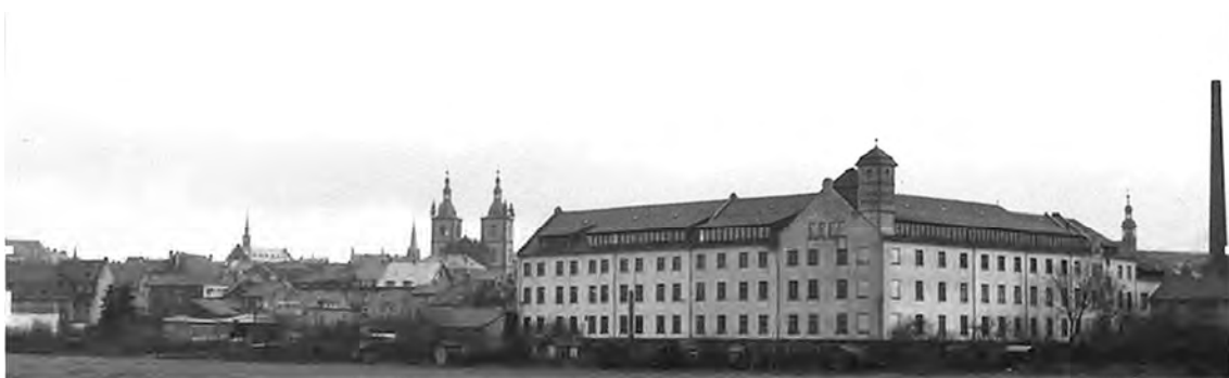
Fulda, 1930er Jahre. Hinter den Löhern Nr. 16 - 22. Die Wollgarnfabrik von der Bardostaße aus gesehen.
