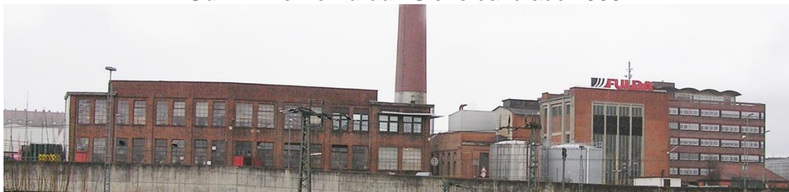
Ansicht der Gummiwerke Fulda am 16.03.2008 von der Künzellerstraße gesehen. Standort des Fotografen: Gelände der Tankstelle Knorr & Herzig, Künzeller Straße 51.
