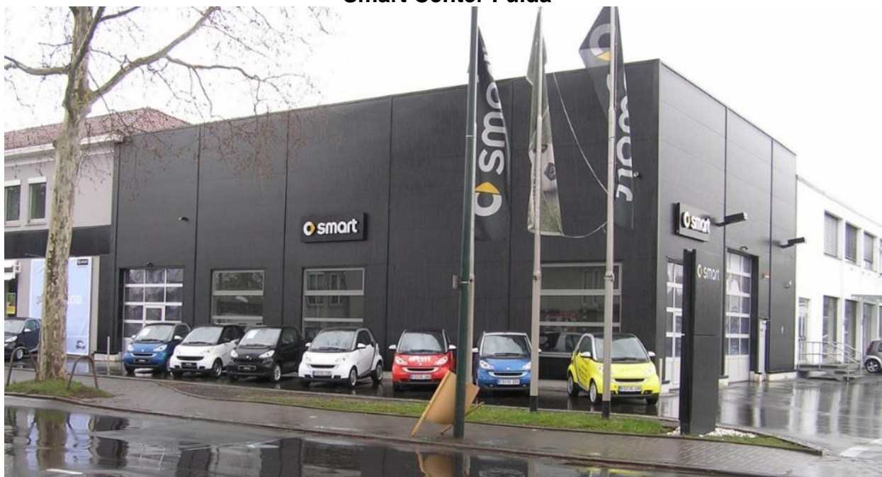
Das „Smart-Center Fulda“, Frankfurter Straße Nr. 125 im März 2008
