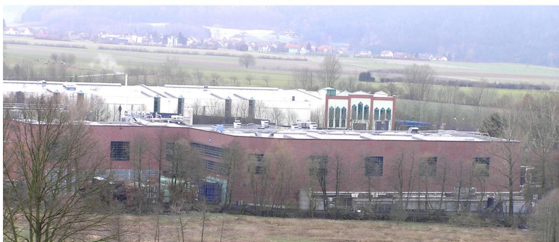
Weyhers, März 2008. Teilansicht des Werkes Mineralbrunnen RhönSprudel Egon Schindel GmbH. Der Gebäudeteil mit den neun hohen Fenstern ist ein Teil der Werksanlage aus den 1950er Jahren. Vergleiche das Größenverhältnis 1950er Jahre zu 2008.
